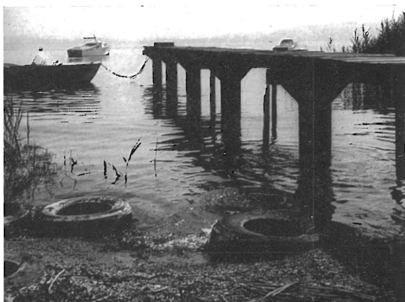
Abb. 15: Naturschutzgebiet Bodenseeuferr; Schilfschneise mit Plattenweg und Laufsteg im Ufervorland vor privatem Seegrundstück
