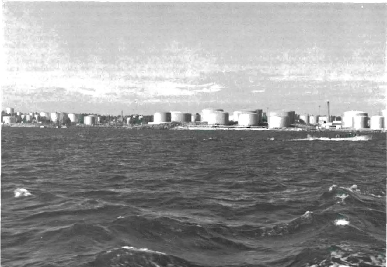
Abb. 7 Ausgedehnte Tankanlagen im Hafen von Stockholm
