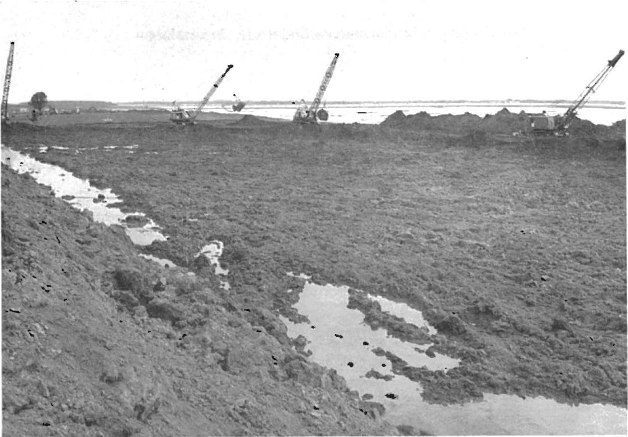
Abb. 39 Bau des neuen Landesschutzdeiches in der Wedeler Marsch (1975)
