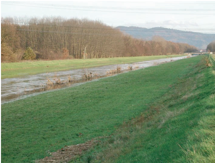
Abb. 8: Der Rench-Flutkanal am Oberrhein mit seinem typischen glatten Doppeltrapezprofil (Foto: S. Röck).
