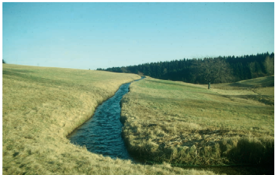
Abb. 4: Das Heidenwuh im Hotzenwald, hier als Hangkanal geführt, ist die Hauptachse eines alten wasserwirtschaftlichen Systems (Foto: W. Konold).
