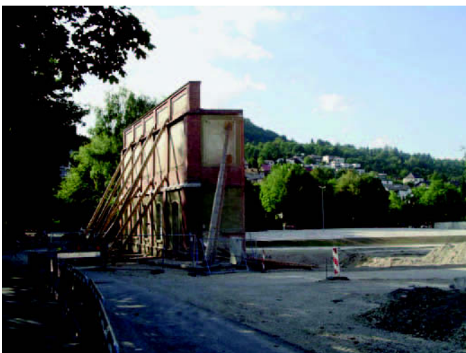
Abb. 3: Abriss eines alten Industrieareals an der Echaz: auf dem Gelände werden Wohnungen entwickelt; die bisher unter einem Gebäude hindurch fließende Echaz (im Bildmittelgrund) konnte offengelegt werden und erhält einen ca. 10 m breiten Uferstreifen mit Fuß- und Radweg. Wertvolle Bausubstanz kann teilweise erhalten werden. (Foto: Küpfer).
