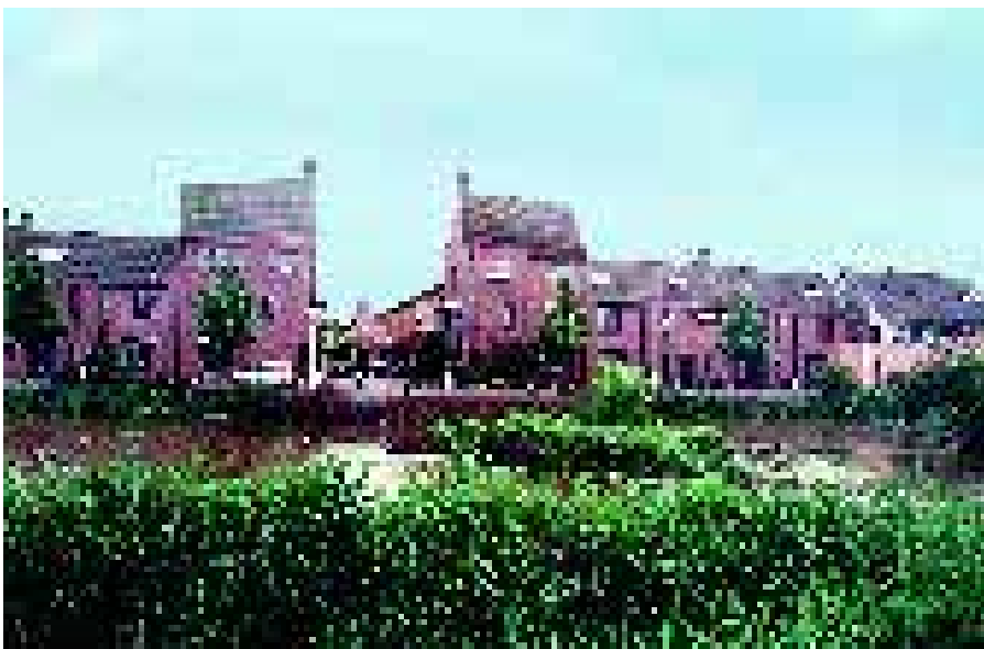
Abb. 2: Ecolonia in Alphen aan den Rijn. See als Auffangbecken für Regenwasser der Hausdächer (Foto: Smaniotto Costa 2002).
