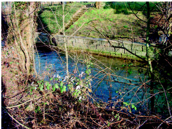
Abb. 5: Hartverbau an der Echaz im Pfullinger Innenstadtbereich vor der Renaturierung (Foto: Geitz).
