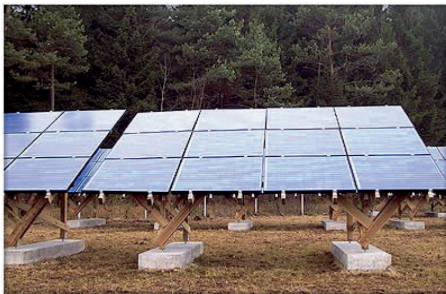
Abb. 3: Betonstreifenfundamente mit Holzaufständering.
