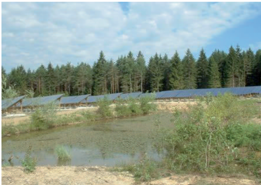
Abb. 2: Biotopgestaltung innerhalb einer Freiflächenanlage.
